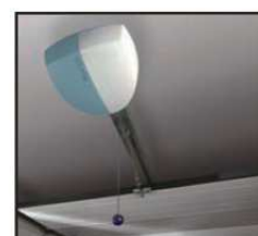
Ochrana proti přimáčknutí a zachycení (zvednutí osob) se vztahuje na vrata montovaná s elektrickým pohonem a je zajištěna instalací certifikovaných pohonů se zabudovanou elektronickou ochranou
